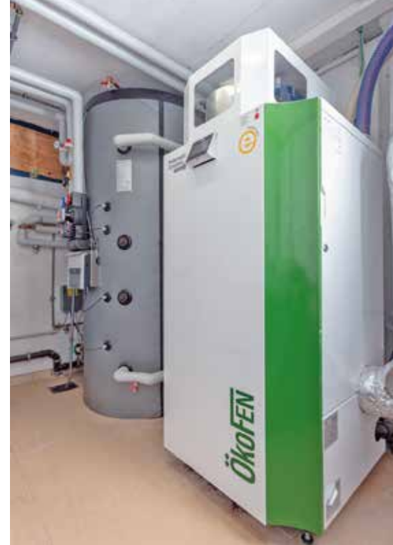
Die Pellematic Condens wird zusammen mit dem Microgen Stirlingmotor zur stromproduzierenden Pelletheizung Condens_e. Sie sind Teil eines Gesamtkonzepts.
