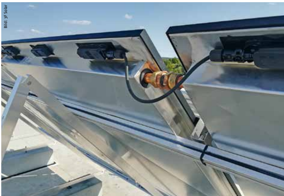
Hybridkollektoren liefern Strom und Wärme von der Sonne. Deshalb müssen sie sowohl hydraulisch verbunden als auch elektrisch verkabelt sein.
