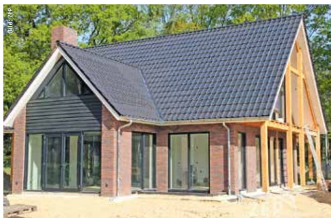
Solardachziegel sind eine Form der gebäudeintegrierten Photovoltaik (BIPV). Die größeren Dachziegelhersteller investieren derzeit alle in BIPV.
