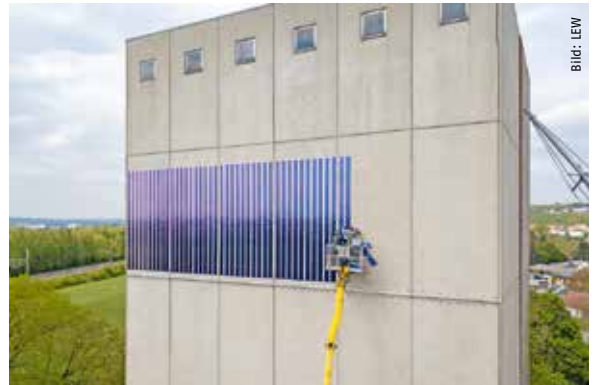
„PV-Tapezierer“ im Einsatz in luftigen 20 m Höhe kleben in einem Pilotprojekt Photovoltaik-Bahnen an die Fassade eines Silos.
